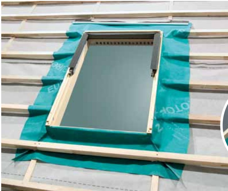
dampfdurchlässiger Folienanschluss mit Dämmstoff
